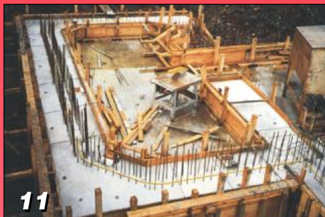
11 Styki płyt fundamentowych ze ścianami
